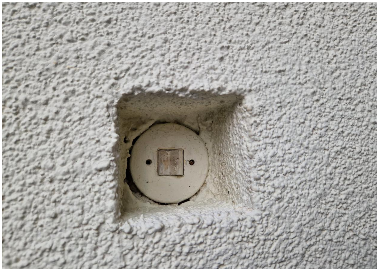
Rysunek 5. Łączniki oświetleniowe na elewacji zewnętrznej, poziom parteru – do usunięcia.
